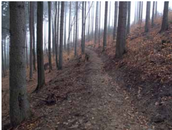
Baronský chodník po provedení výkopových prací
