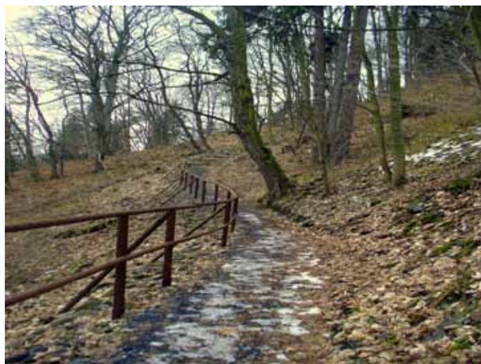
Nevhodná úprava - instalace zábradlí. Zábradlí vyzývá uživatele k pohybu po vnější hraně, která je přitom nejkřehčí částí tělesa stezky. Důsledkem toho může dojít k propadání až utržení vnější hrany stezky (Františkov nad Ploučnicí)
