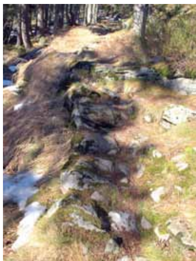
Stezka vyskládaná z velkých balvanů v obtížně přístupném terénu (Grosser Arber, Šumava)
