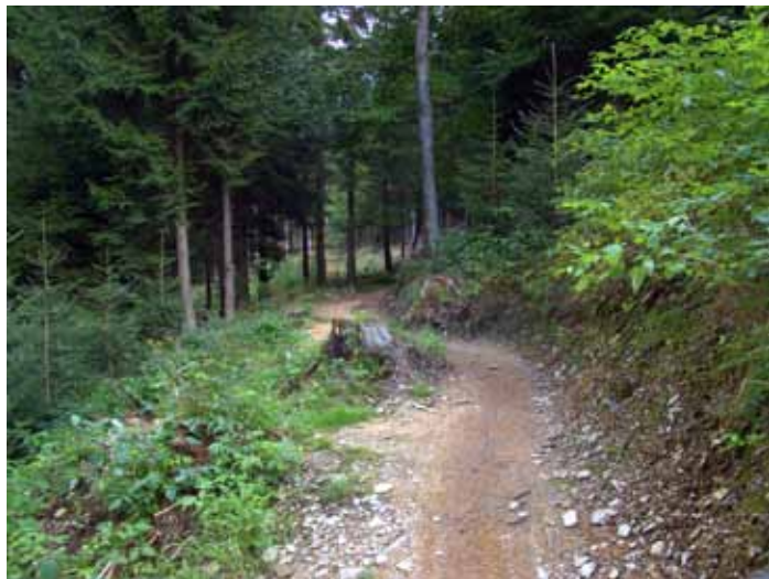
Nová stezka jeden rok po dokončení, výkopový svah rychle zarůstá mechem (Singltrek pod Smrkem)
