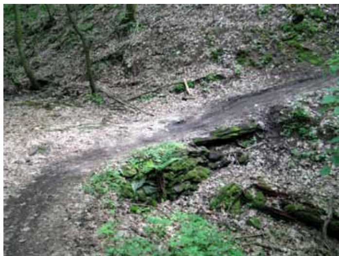
Vyskládaná suchá zídka na průchodu stezky roklič (stezka v Záběle u Plzně). Zídka tvořící vnější hranu stezky jsou velmi nenápadným, avšak poměrně častým jevem.
