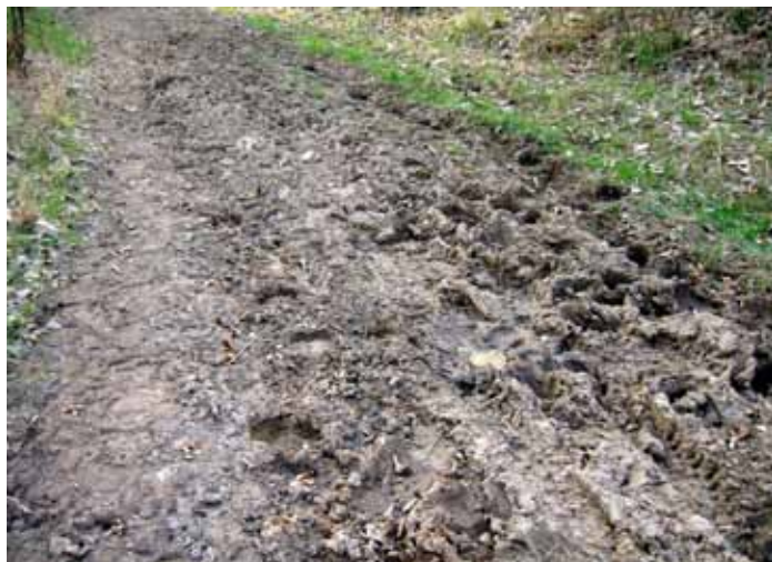
Povrch stezky poškozený koňskými kopyty. Důsledkem pohybu koní je zhoršen přístup pro ostatní uživatele (Soběšice u Brna)
