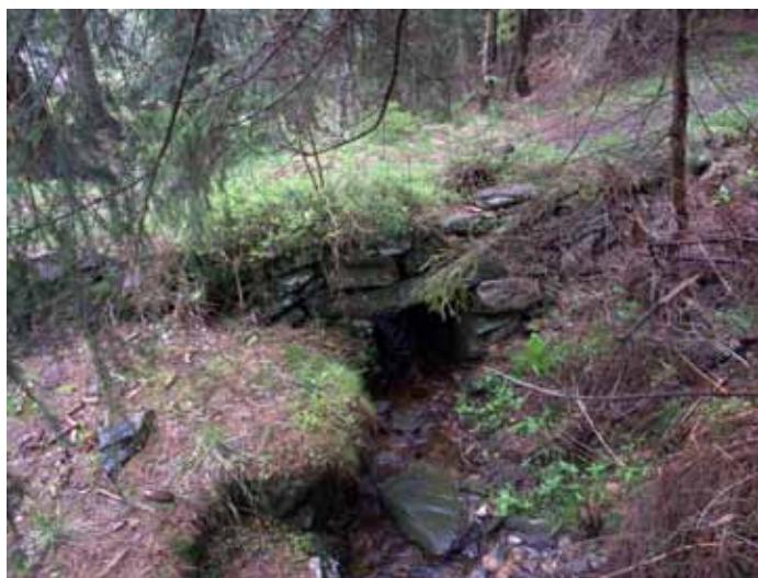
Můstek přes potok z nasucho vyskládaných kamenů (Krkonoše)
