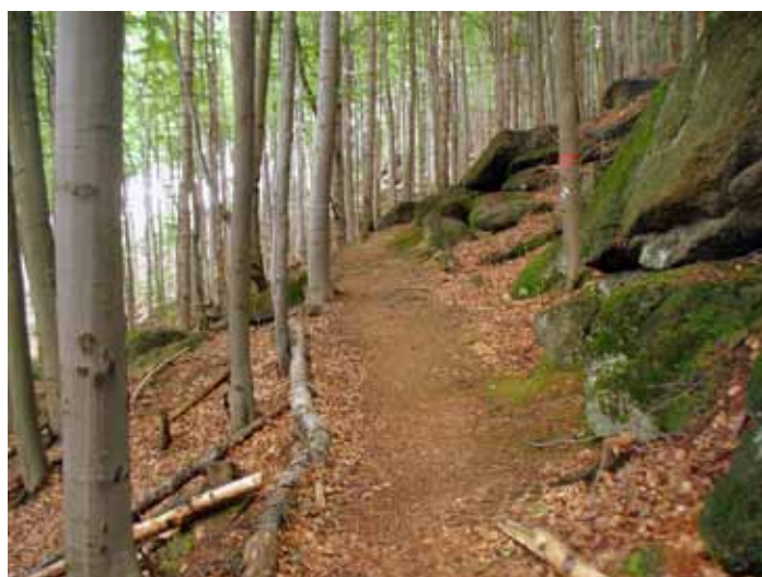
Nevhodná úprava stezky - roubení vnější hrany. Podél roubení se usazuje napadaný tlející organický materiál, který zadržuje vodu. Voda zadržovaná v profilu stezky může způsobit rozbahnění stopy a utržení či propadnutí vnější hrany (Oldřichovský Špičák, Jizerské hory)
